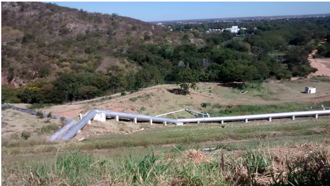
Figura 02: Distribuição de água da Barragem Bico da Pedra para os lotes irrigados
